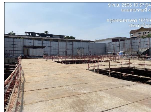
ภาพที่ 18 ปูแผ่นเหล็ก
